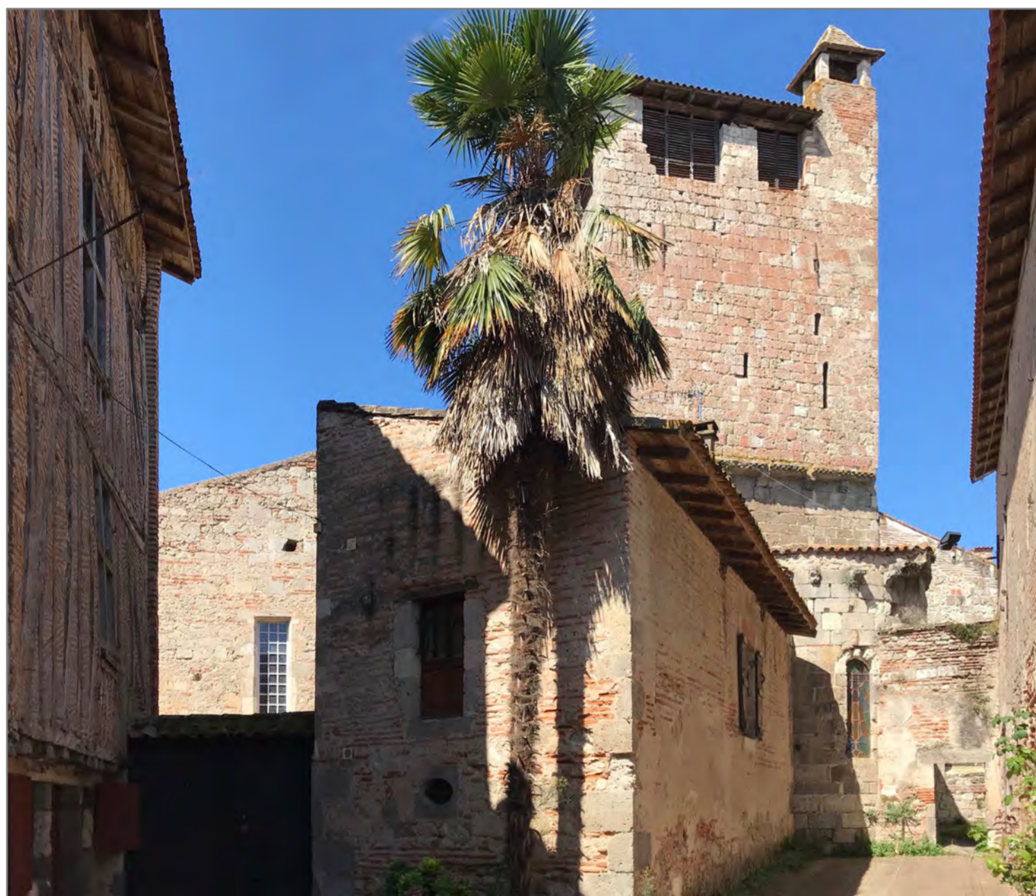
Construit en beaux moellons de pierre de Thabor, encadré d'anciennes constructions de brique, le clocher-fortifié de Clairac est un joyau unique de la région Nouvelle-Aquitaine.
