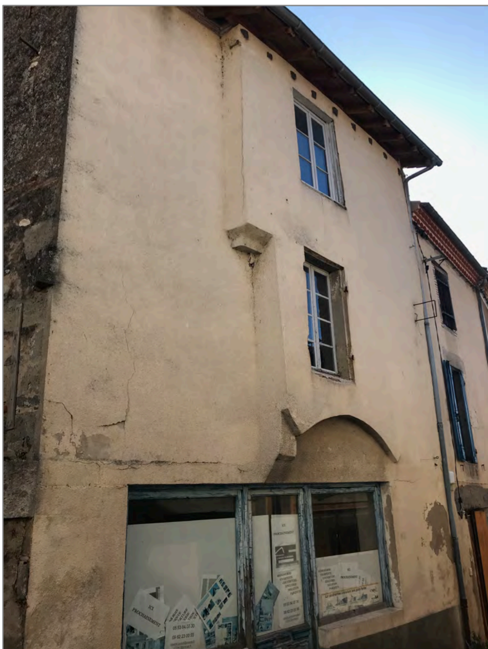
Rue des Treilles, tout indique que les pans de bois sont là !
