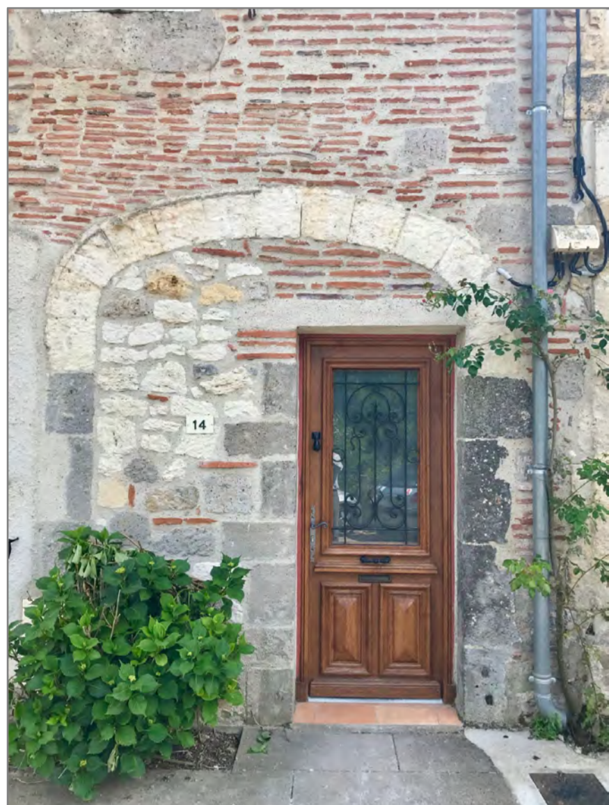
14 quai Gambetta, la restauration de la façade a mis en évidence la transformation.
