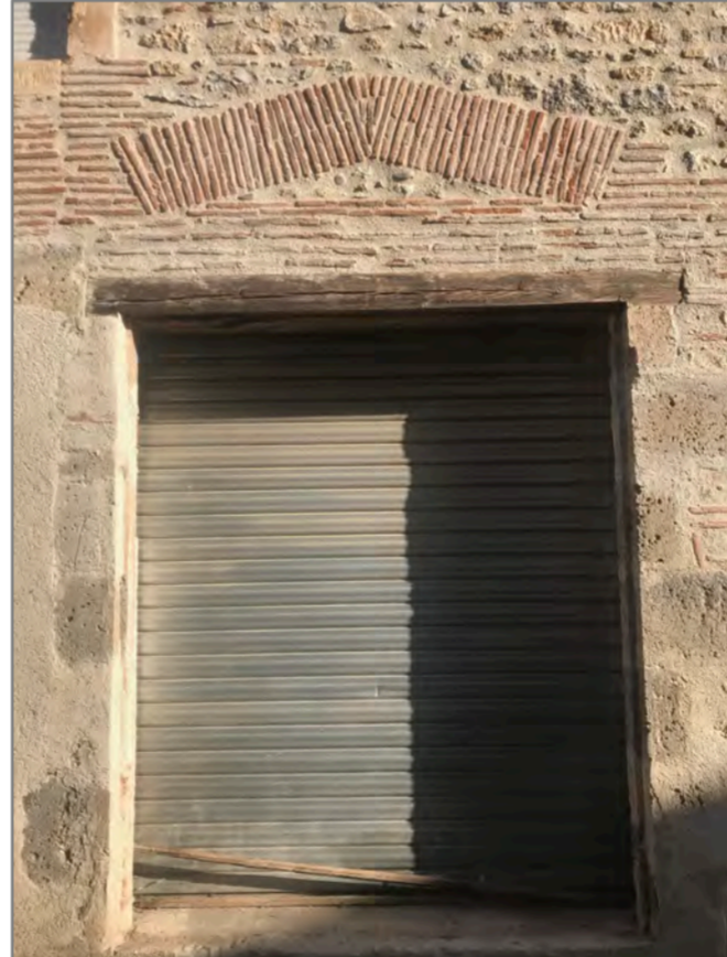
Rue du Pressoir, un arc de décharge en briques répartit le poids du mur sur cette ouverture.
