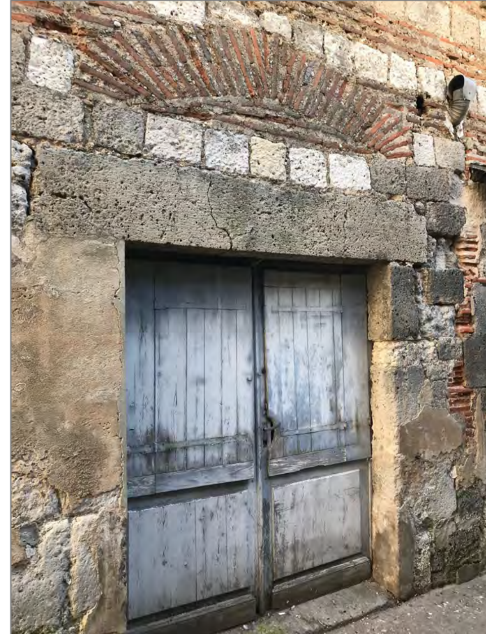
Rue Traversière, savant assemblage de briques pour l'arc de décharge, pierre de Tabor (admirez la portée du linteau) et calcaire de Lacépède.
