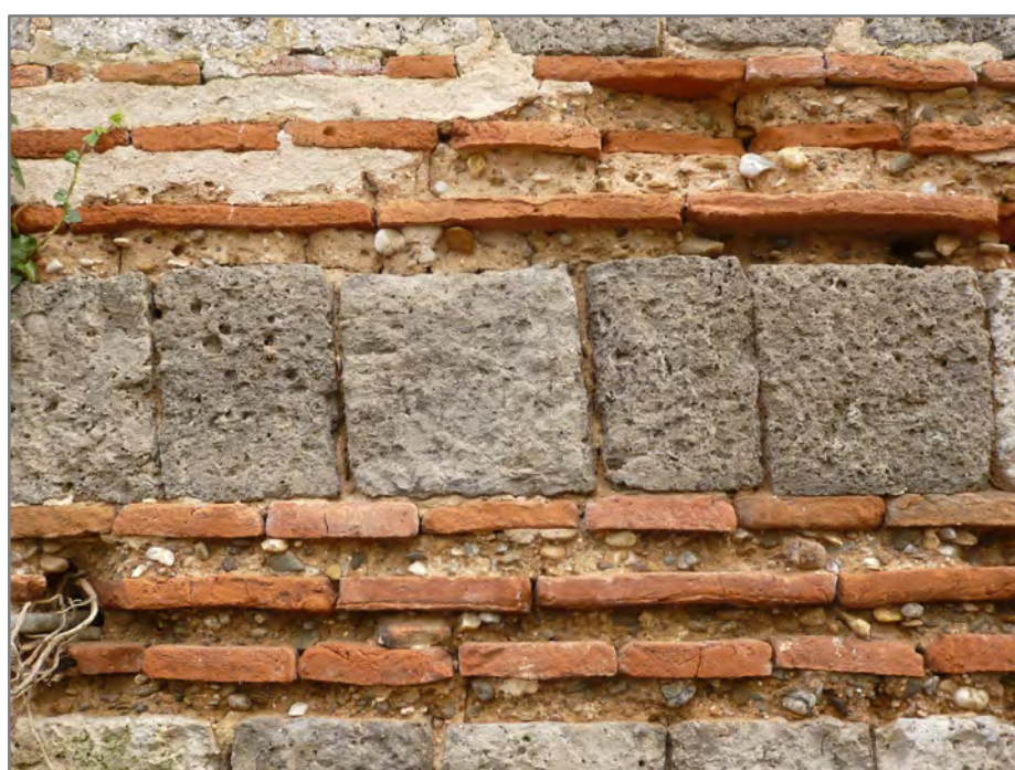
Trois rangs de briques, un rang de Thabor, trois rangs de briques. Continuer ad libitum ...
