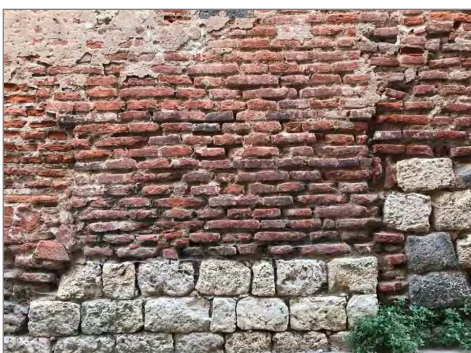
Rue Jeanne-d'Arc, une assise en pierre pour stabiliser et protéger l'édifice, puis une élévation en briques épaisses du XVI e siècle.
