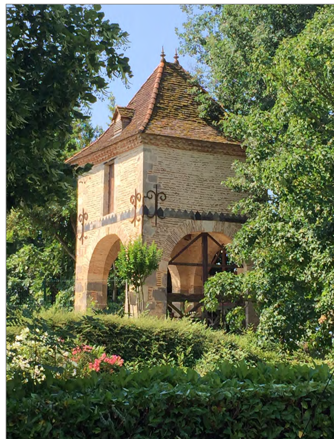
Dans le parc des Capucins, un pigeonnier typique du Clairacais. Murs en brique, angles en pierre, cerclage en ardoise contre les rongeurs, génoise en tuiles canal, toit en tuiles plates... Tous les matériaux sont au rendez-vous !
