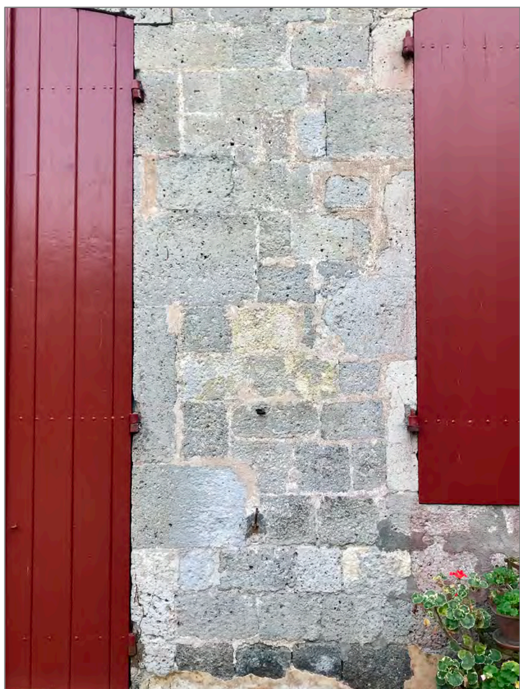
Rue Anatole-Larrat, une façade en moellons réguliers de pierre de Thabor.
