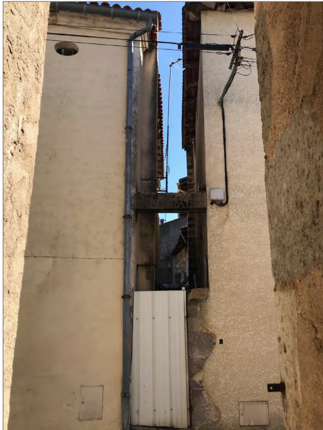
Rue Anatole-Larrat, celui-ci a été fermé par de simples tôles. Le linteau de pierre Thabor permettait de stabiliser les maisons entre elles.
