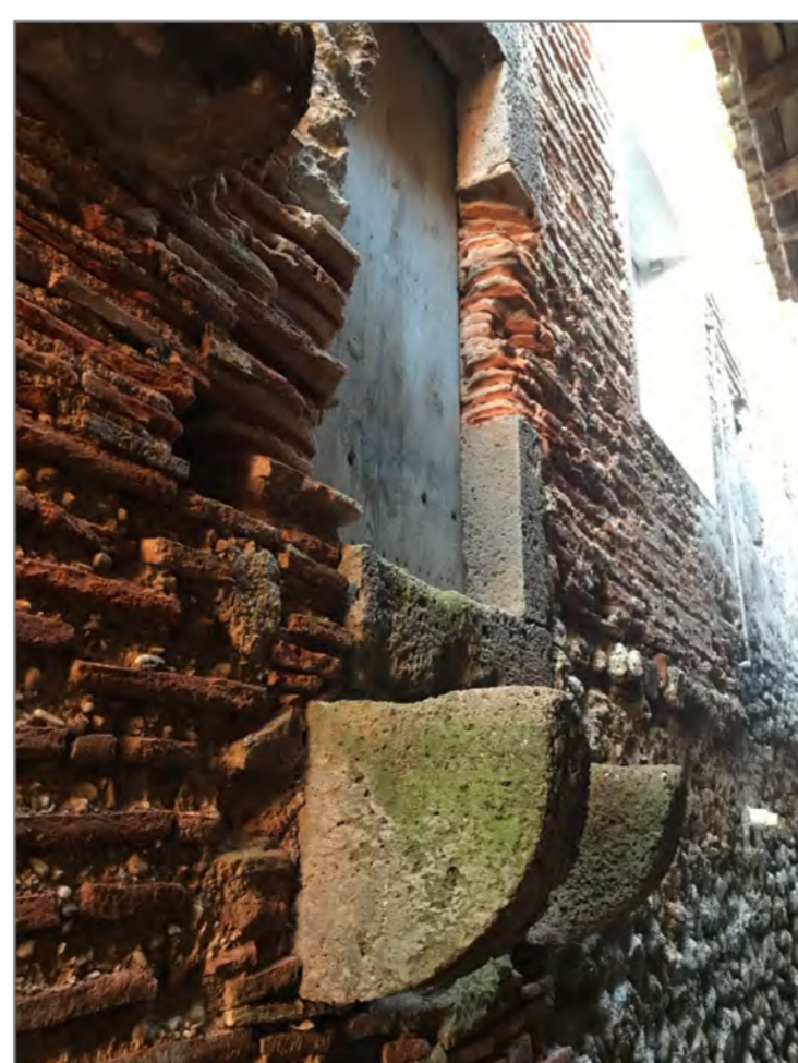
Ces imposants corbeaux de pierre supportaient-ils un balcon pour charger ou décharger des marchandises ?
