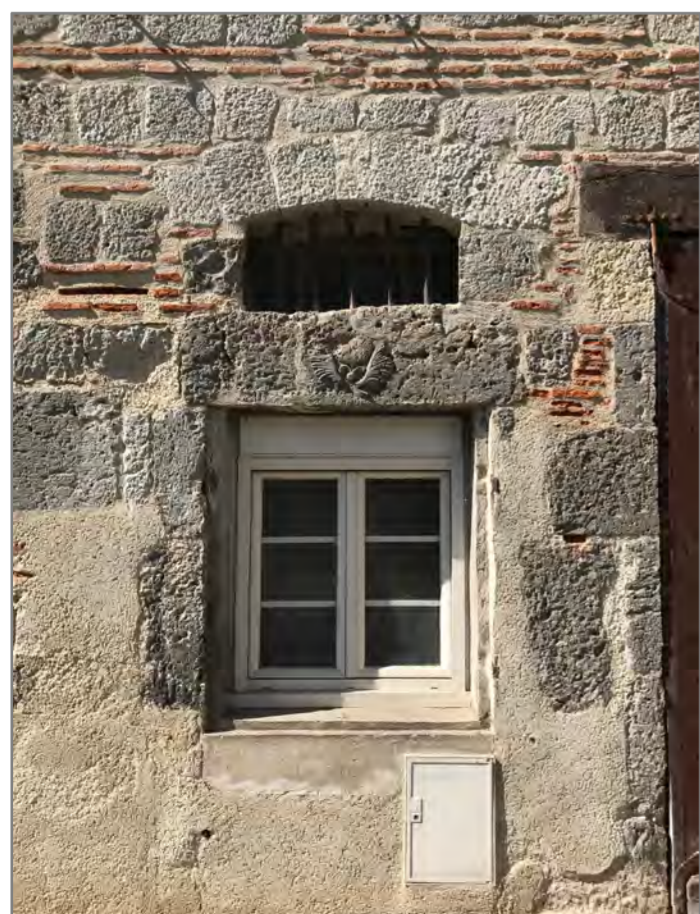
6 rue Anatole-Larrat, le linteau sculpté de l'ancienne porte de la maison des notaires Chaumel est en solide pierre de Thabor.
