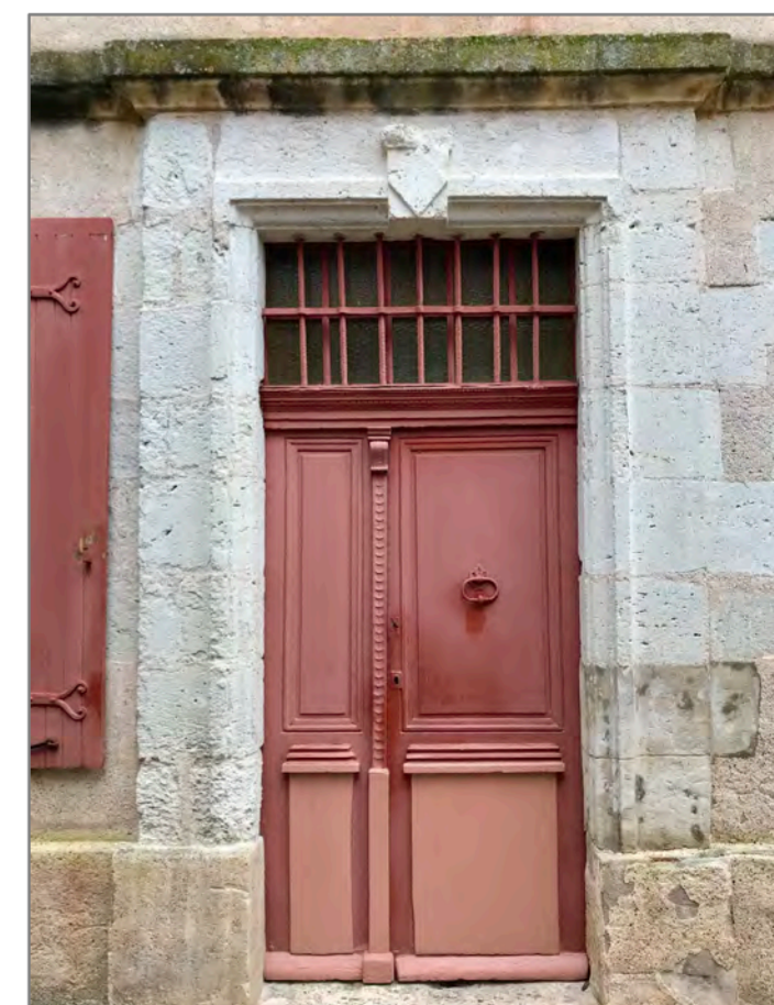
Pour leur maison de ville rue Puzoque, les Labat de Vivens ont choisi le lumineux calcaire de Lacépède.
