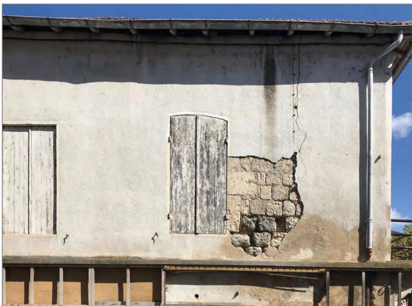
33 rue Gambetta, l'enduit de cette maison qui semble modeste masque un bel appareillage régulier. Nous sommes au cœur du village, à proximité du premier temple protestant, démoli en 1685.
