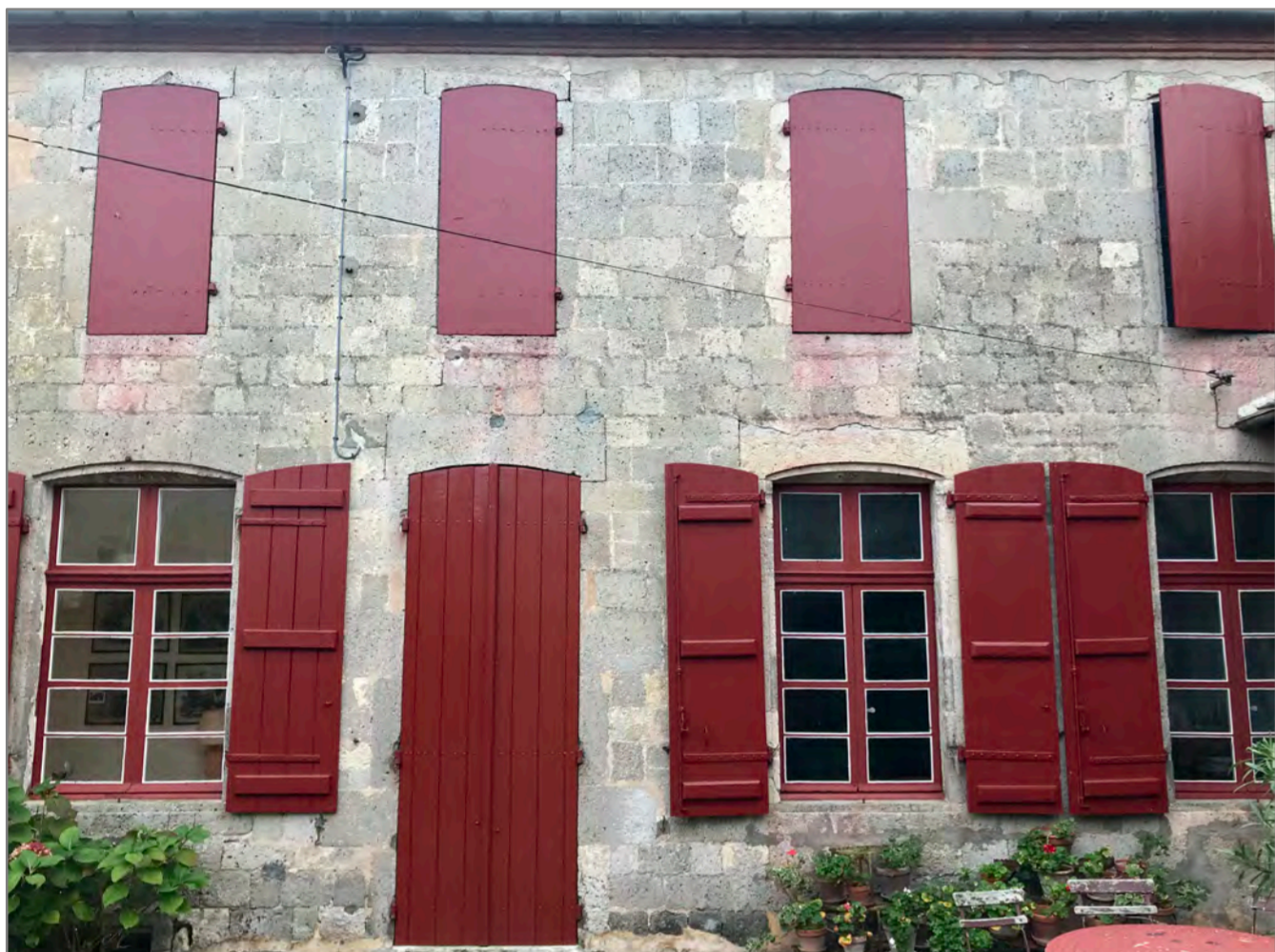
Rue Anatole-Larrat, la maison Denis offre un bel exemple d'une façade entièrement en moellons de pierre de Thabor.
