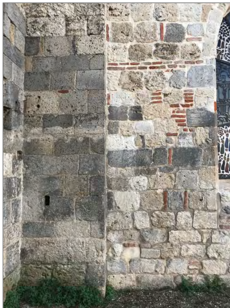
Au chevet de l'église, notez la différence d'appareillage entre le contrefort roman (à gauche) et le mur de la chapelle gothique nord.
