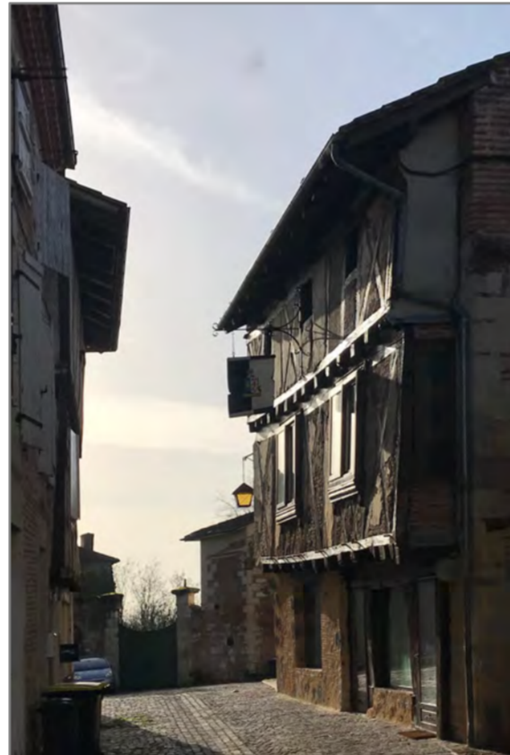
Rue de l'Église, celui-ci permet à chaque niveau d'être plus grand que celui du dessous... Les sablières horizontales luisent dans le soleil du matin.
