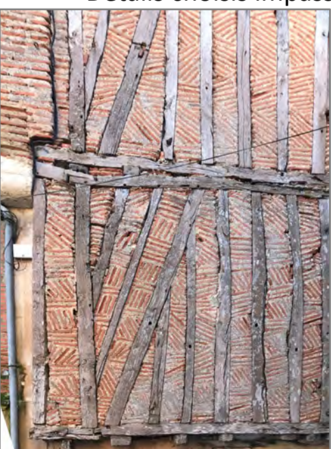
Guettes (en biais) et potelets (verticaux).
