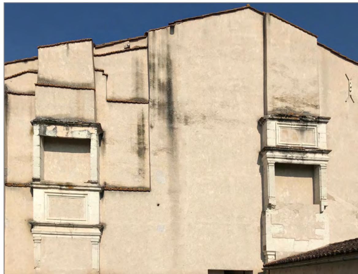
Où trouve-t-on des cheminées perchées ? Rue Puzoque, uniques vestiges de ce que l'on appelait « le château ».
