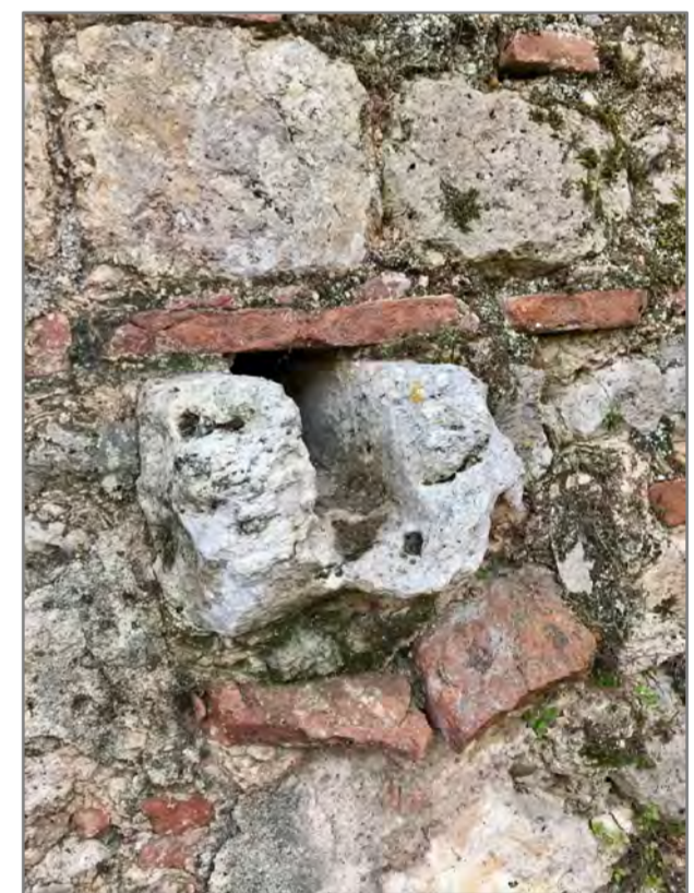
Certains se demandent ce que sont ces excroissances de pierre dans les murs... l'évacuation d'un évier, quand le tout-à-l'égout n'existait pas.
